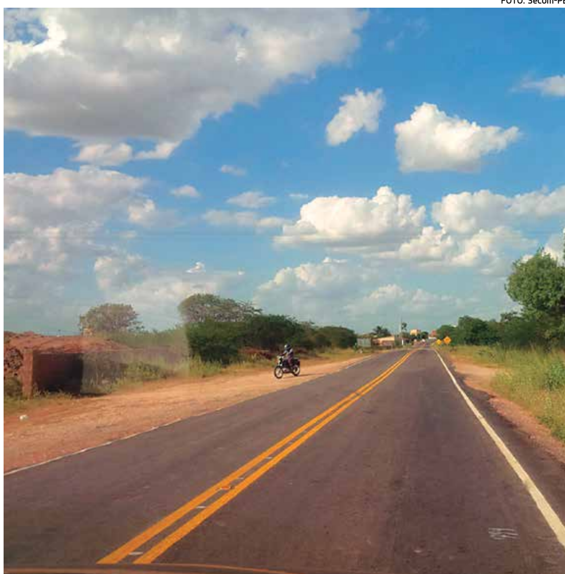
Na rodovia PB-221, o Governo do Estado investiu recursos próprios da ordem de R$ 2.596.418,00
